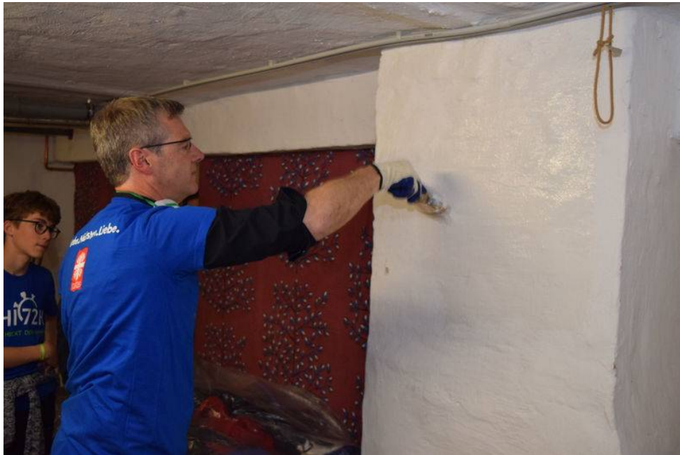
© Bischof Dr. Heiner Wilmer beim Streichen in den Kellerräumen des Mittagstischs. © Broermann / kpg
